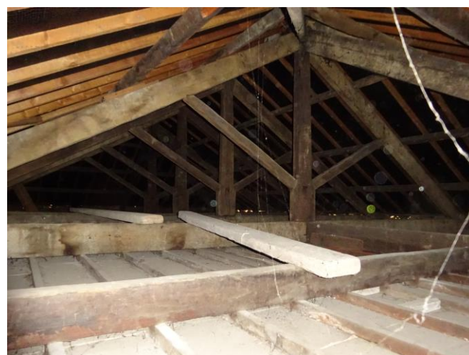
37. R1 roof void
